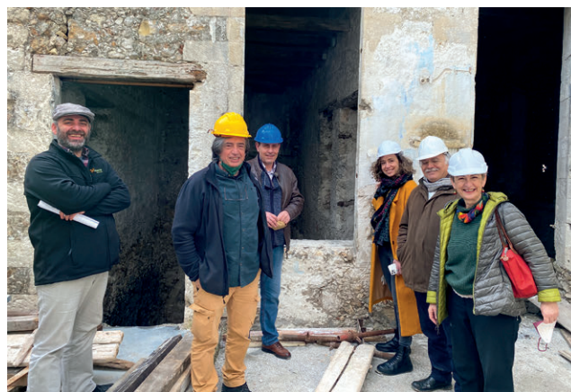
ΕΙΚΟΝΑ 5.5 Το νέο κτίριο στην Αθανασίου Διάκου, υπό κατασκευή, 2021.
